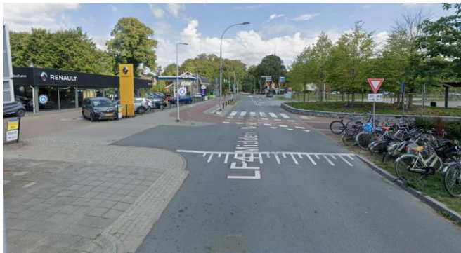
Figuur 3-30: Door de combinatie van de inrit voor het tankstation, de bocht direct voor de fietsoversteek en frequent parkerende autotrailers ontstaat een gevaarlijk wegbeeld. De knipperlichten bij de fietsoversteek helpen onvoldoende
