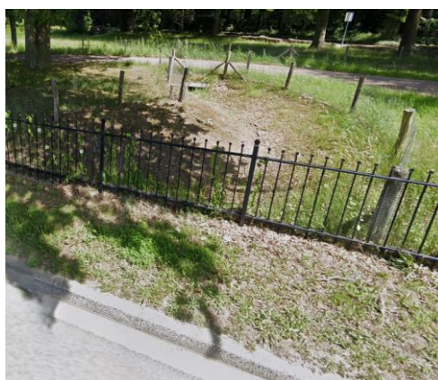
Figuur 2-13: Bij deze ecopassage onder de Hoofdstraat lopen reeën vast, althans is het niet eenvoudig meerdere hekwerken te passeren en tegelijkertijd ook de vierbaansweg
