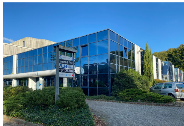
Bestaande kantoren in het gebied
