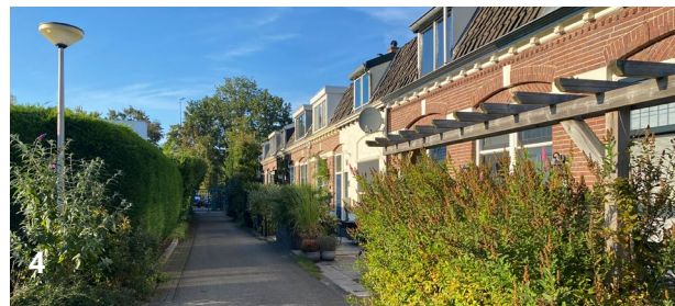
Voormalige arbeiderswoningen bij de Zeister Machinefabriek
